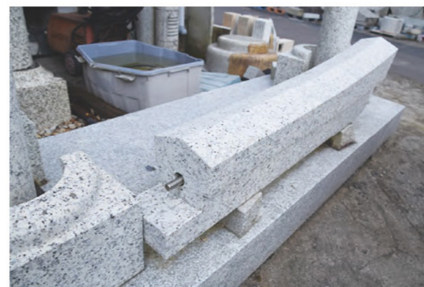
耐震加工が施された鳥居①
