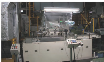
必要な部分に塗料を直接塗る「ディスペンサ方式」を用いた天板内面補修塗装機
